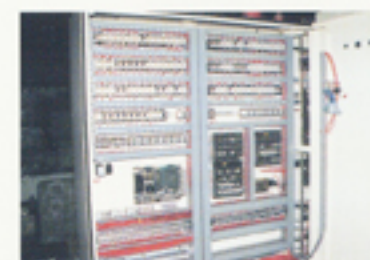
制御盤配線入替
